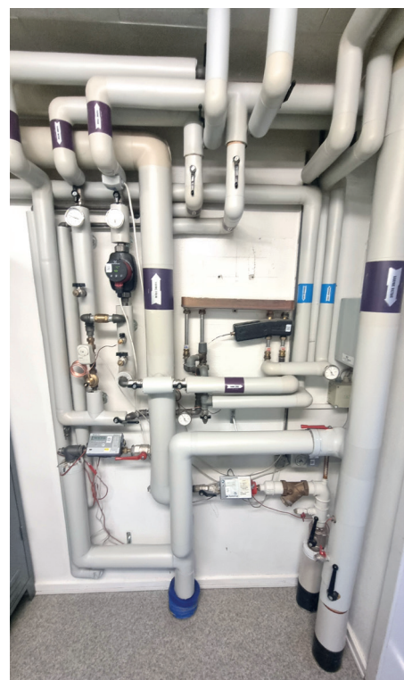
Fjernvarmeinstallation på Hammershusvej. Foto: Herning Kommune
